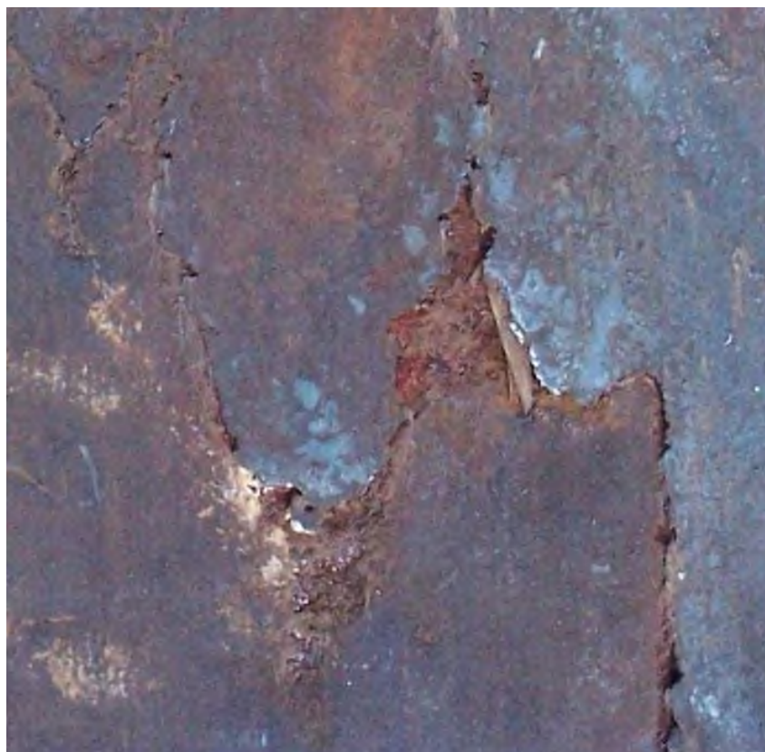
Рисунок 6.9 – Макрофотография дефекта «Гнездообразная трещина»
