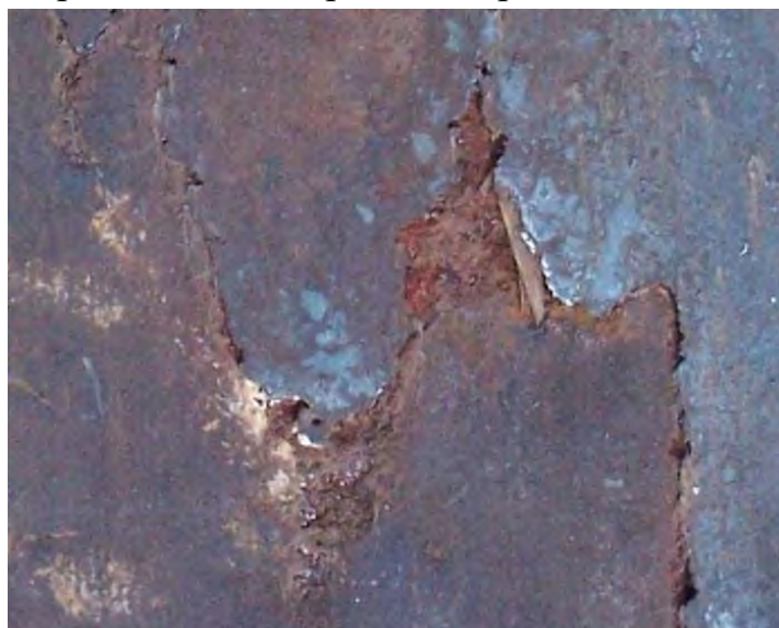
Рисунок 11 – Макрофотография дефекта «Гнездообразная трещина»
