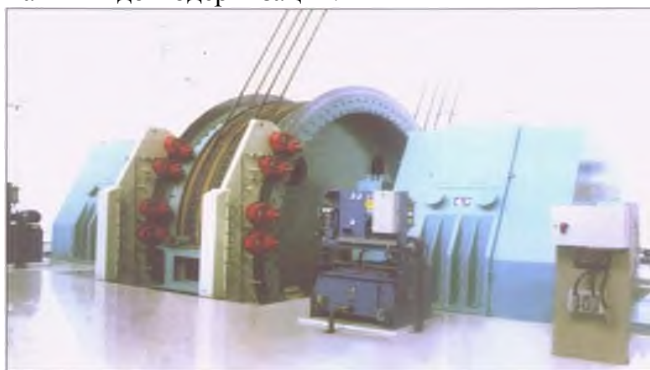
Рис. 1 - Шахтная подъемная машина
