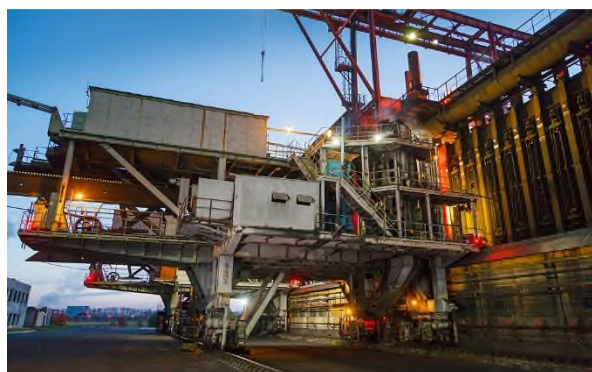
Рис. 2 – Коксовыталкиватель батареи классического слоевого коксования
