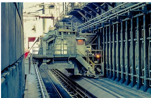
Рис. 4 – Двересъемная машина батареи классического слоевого коксования
